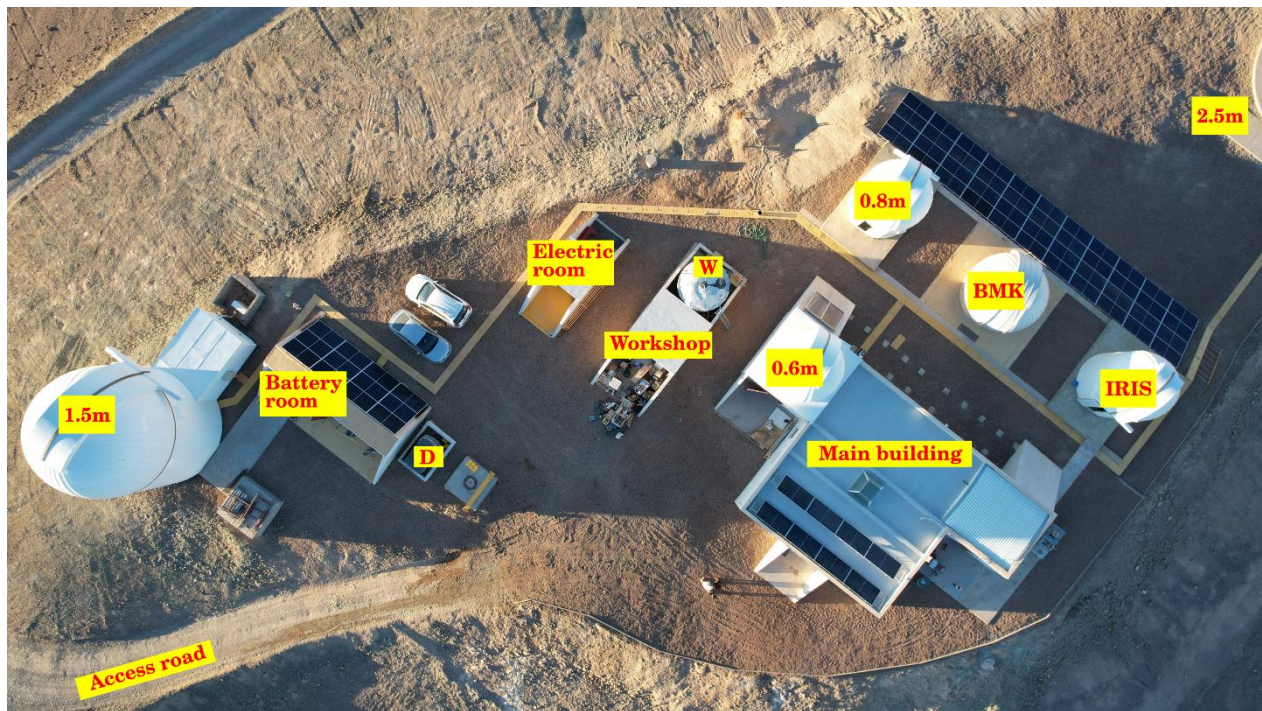
Zdjęcie 1 Lokalizacja budynków i urządzeń w OCM. TMMT zostanie zainstalowany na szczycie istniejącego betonowego bloku widocznego po prawej stronie zbiornika oleju napędowego oznaczonego jako „D”
