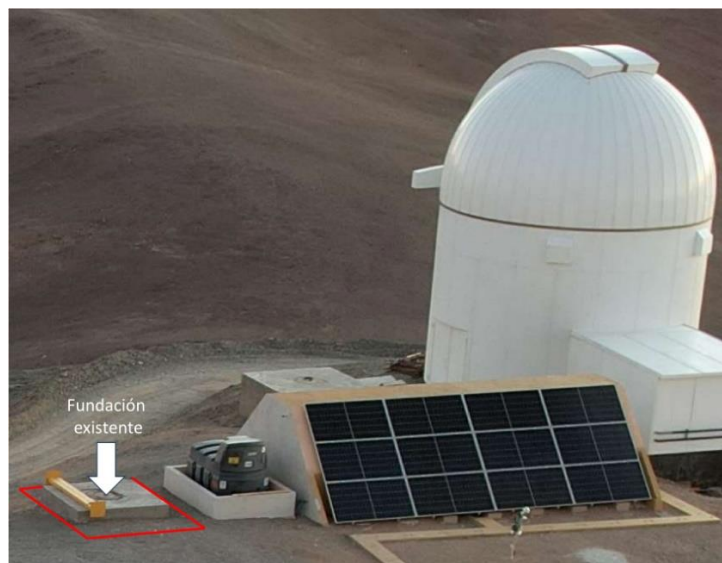
Zdjęcie 2 Istniejący fundament widziany z północy; czerwone kontury oznaczają przewidywane powiększenie istniejącego fundamentu
