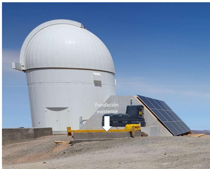
Zdjęcie 3 Istniejący fundament widziany od strony wschodniej; jego wymiar pionowy to ok. 30 cm nad ziemią
